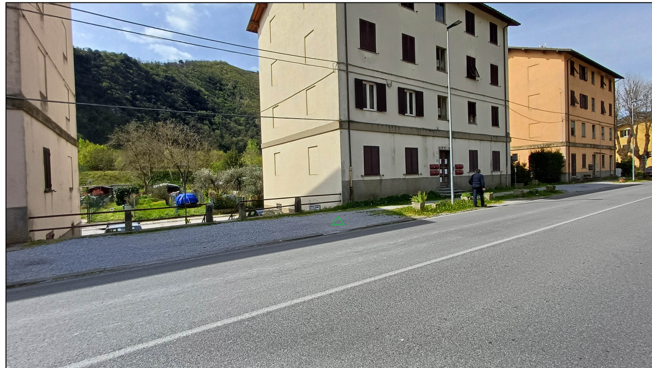
fotografia dello stato attuale
