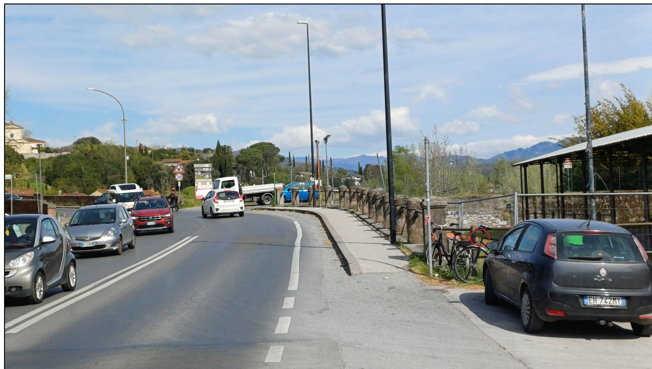
Fotografia dello stato attuale
