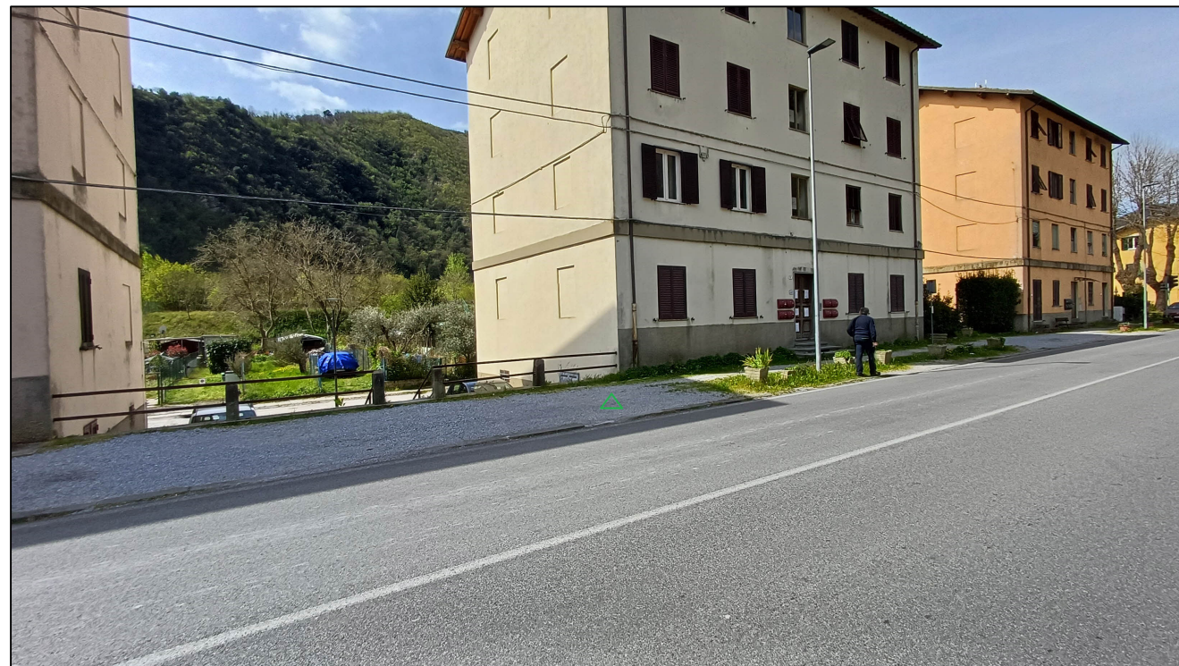
fotografia dello stato attuale
