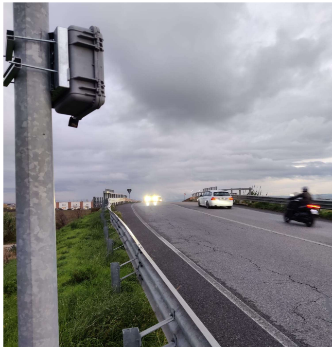
Figura 3.1 – Esempio di installazione di radar
