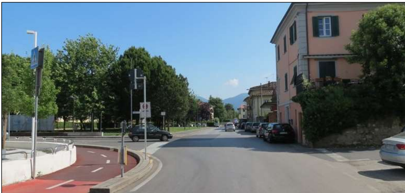
Figura 6 Vista dell'area di intervento Via della Formica
