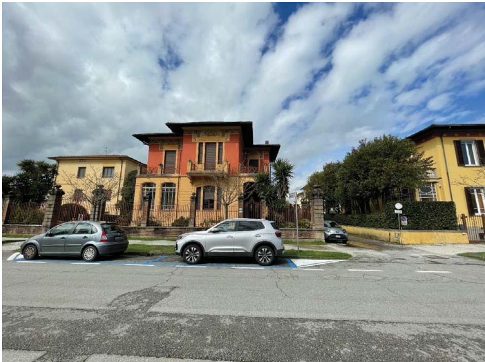
4 Primo tratto della Via Pascoli: vista su ingresso via privata Versilia, lato ovest
