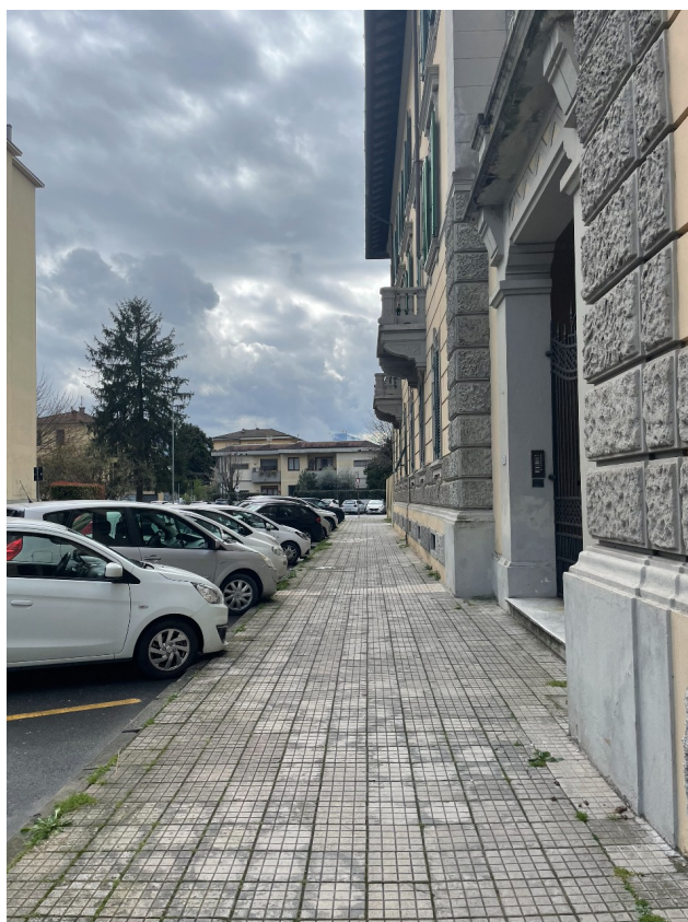
11-12_Via Pascoli, secondo tratto lato ovest, pavimentazione tipo "cioccolato"
