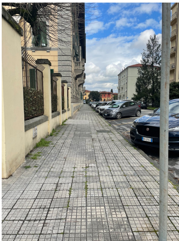
11-12_Via Pascoli, secondo tratto lato ovest, pavimentazione tipo "cioccolato"
