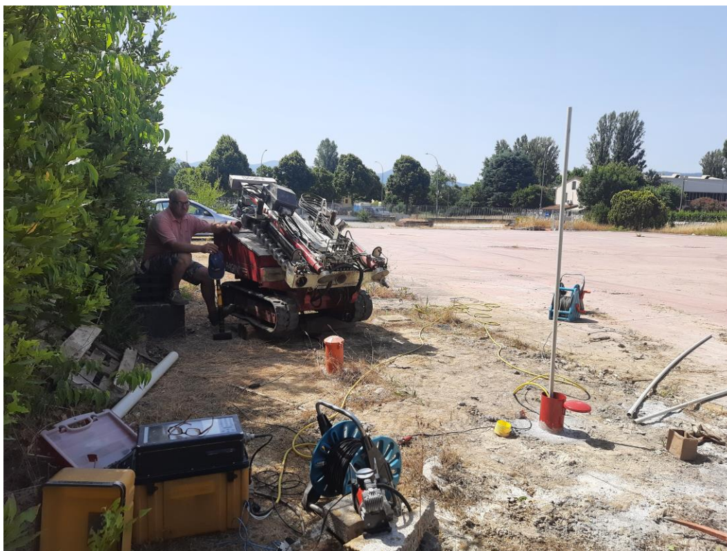
Vista d'insieme del cantiere della DH. A sx il prospettore Geometrics Smartseis S24; in secondo piano il dispositivo di energizzazione delle onde di taglio (traversina sovraccaricata dal peso del penetrometro).
