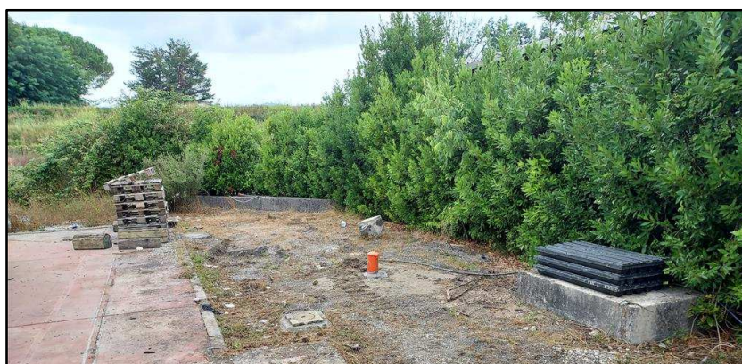
Figura 5: Completamento (Chiusino e deposito cassette)
