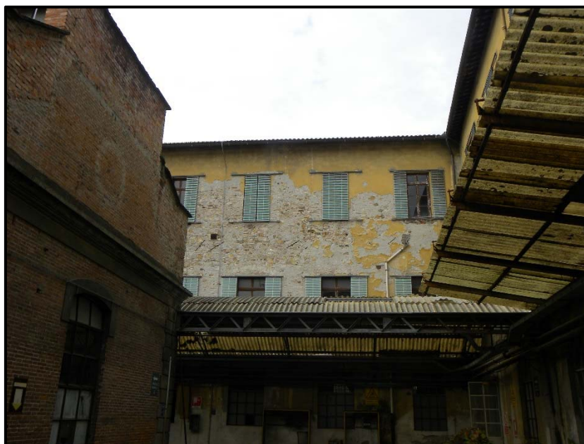
Figura 3 – Prospetto Sud- Particolare della tipologia di muratura
