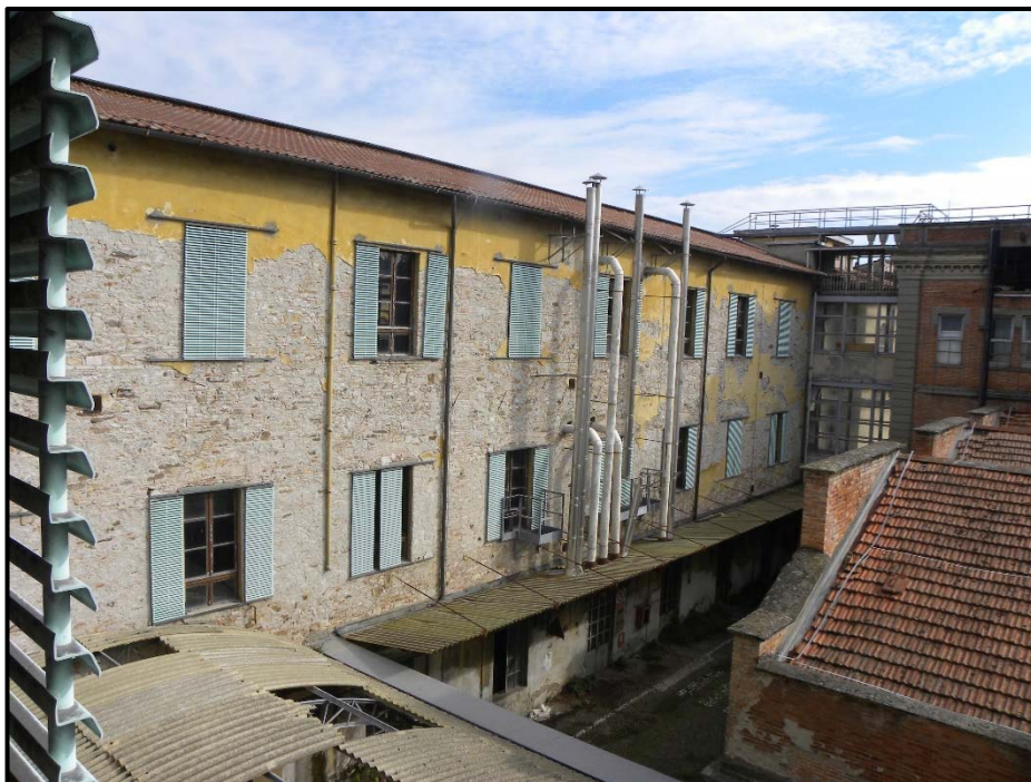
Figura 1 – Prospetto Sud- Particolare della tipologia di muratura
