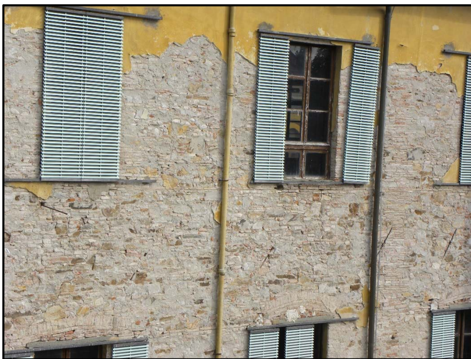
Figura 2 – Prospetto Sud- Particolare della tipologia di muratura
