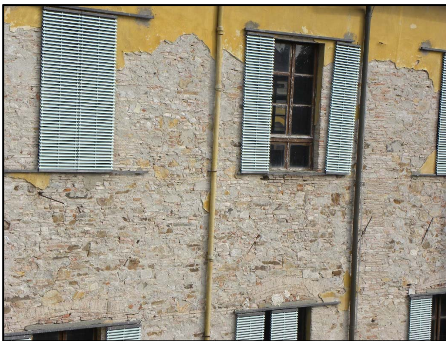
Figura 3 – Prospetto Sud- Particolare della tipologia di muratura
