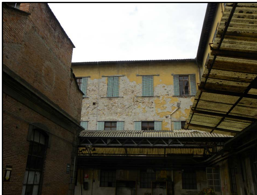
Figura 4 – Prospetto Sud- Particolare della tipologia di muratura
