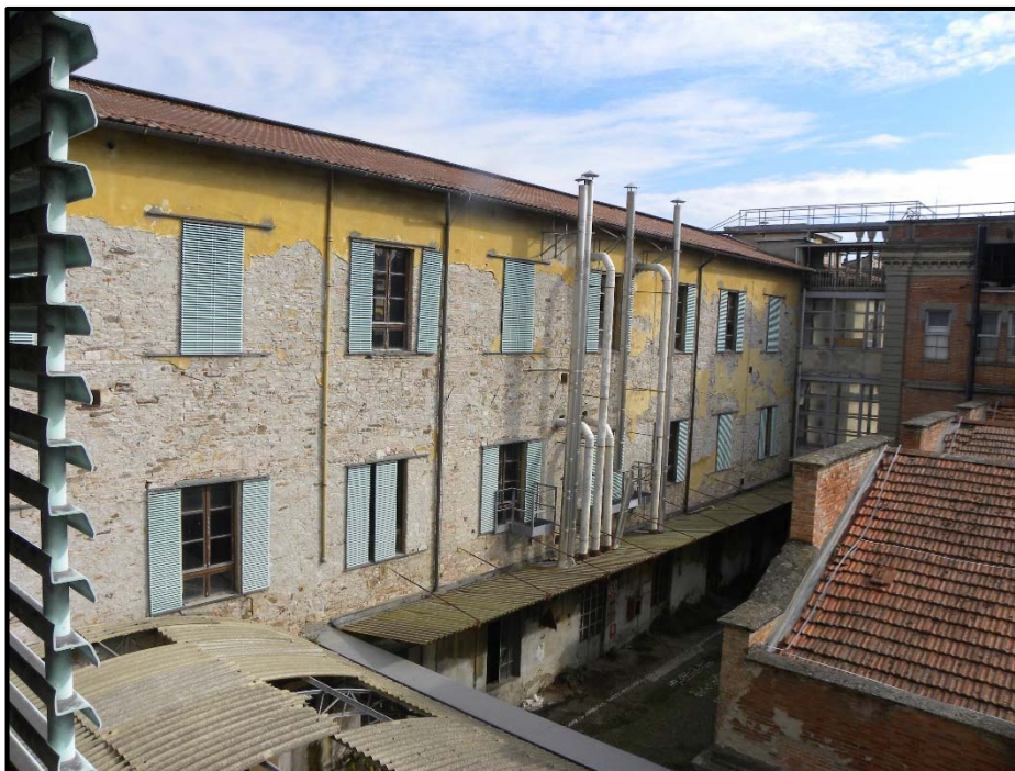
Figura 2 – Prospetto Sud- Particolare della tipologia di muratura
