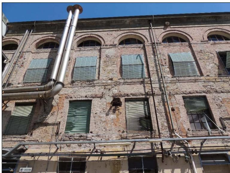
**Figura 3 –Prospetto Ovest-** Particolare delle inclusioni in pietrame nel paramento in mattoni pieni
