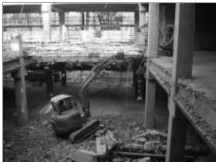
Fig. 23 – Demolizione con utensile a martello
