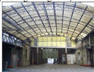
Fig. 6 – Vista interna della tettoia da demolire
