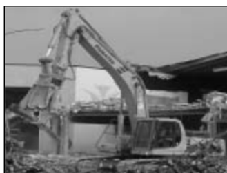
Fig. 22 – Cabina con protezione F.G.P.S.
