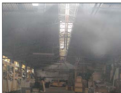
Fig. 8 – Vista interna capannone a struttura metallica
