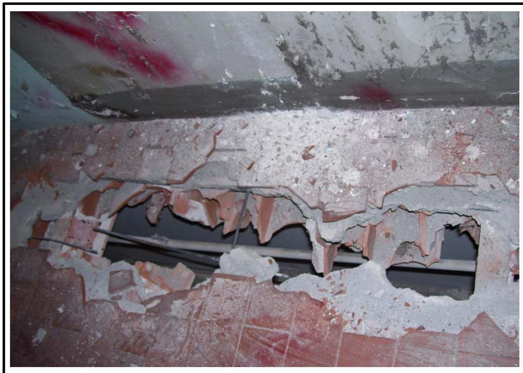
**Fig. 16 – Centro di competenza di tecnologie, arti e spettacolo: Saggio su orizzontamento piano.**
