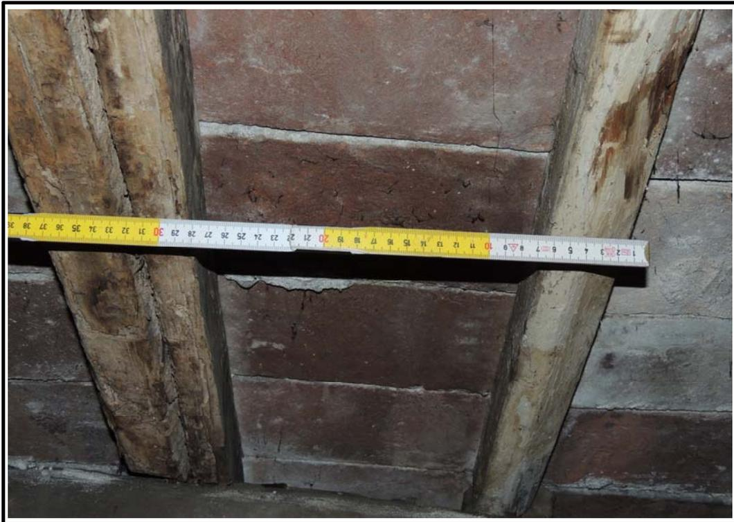
**Fig. 21 – Centro di competenza di tecnologie, arti e spettacolo: rilievo dell’orditura minuta del tetto.**
