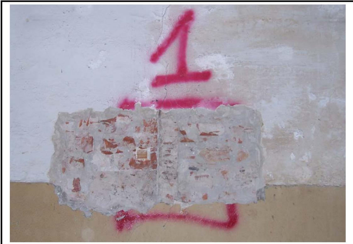
**Fig. 7 – Centro di competenza per lo sviluppo e l'insediamento d'impresa ad alta innovazione tecnologica: Saggio sulla muratura – Per la documentazione fotografica completa dei saggi, si rimanda agli elaborati grafici IM-PS.TAV.01 e 02.**
