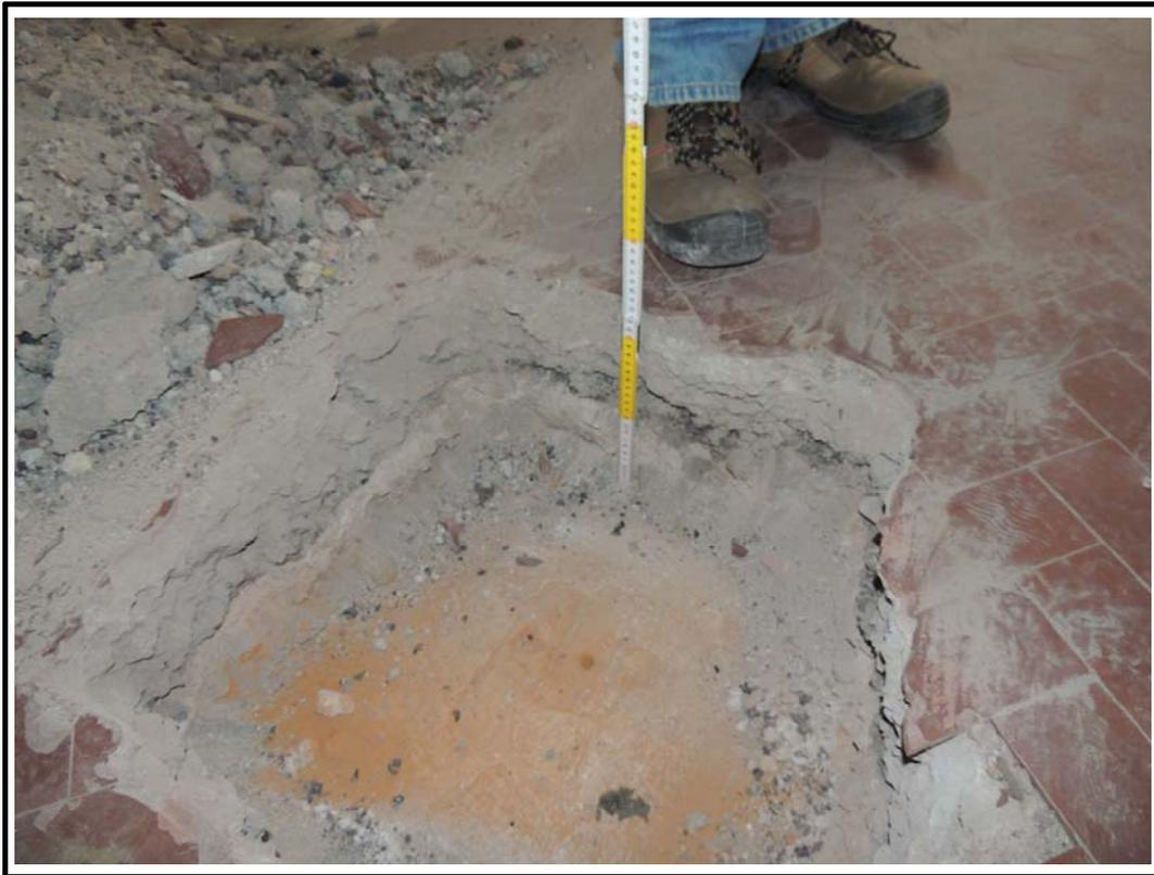
**Fig. 17– Centro di competenza di tecnologie, arti e spettacolo: Saggio su orizzontamento voltato.**
