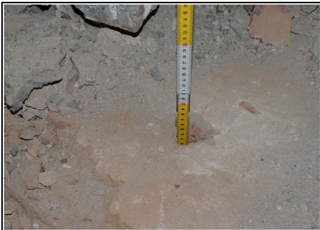
**Fig. 18 – Centro di competenza di tecnologie, arti e spettacolo: rilievo dello spessore strutturale degli elementi voltati.**
