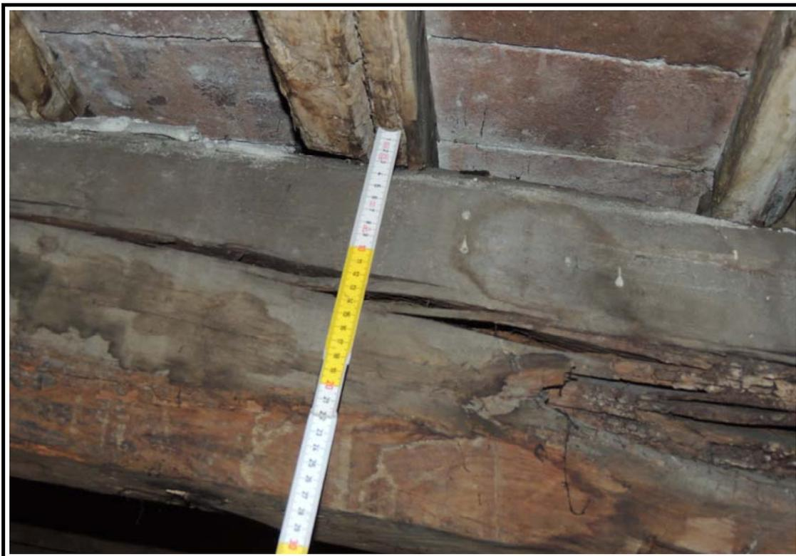
**Fig. 9 – Centro di competenza per lo sviluppo e l'insediamento d'impresa ad alta innovazione tecnologica: rilievo degli elementi linei delle capriate che sostengono la copertura.**
