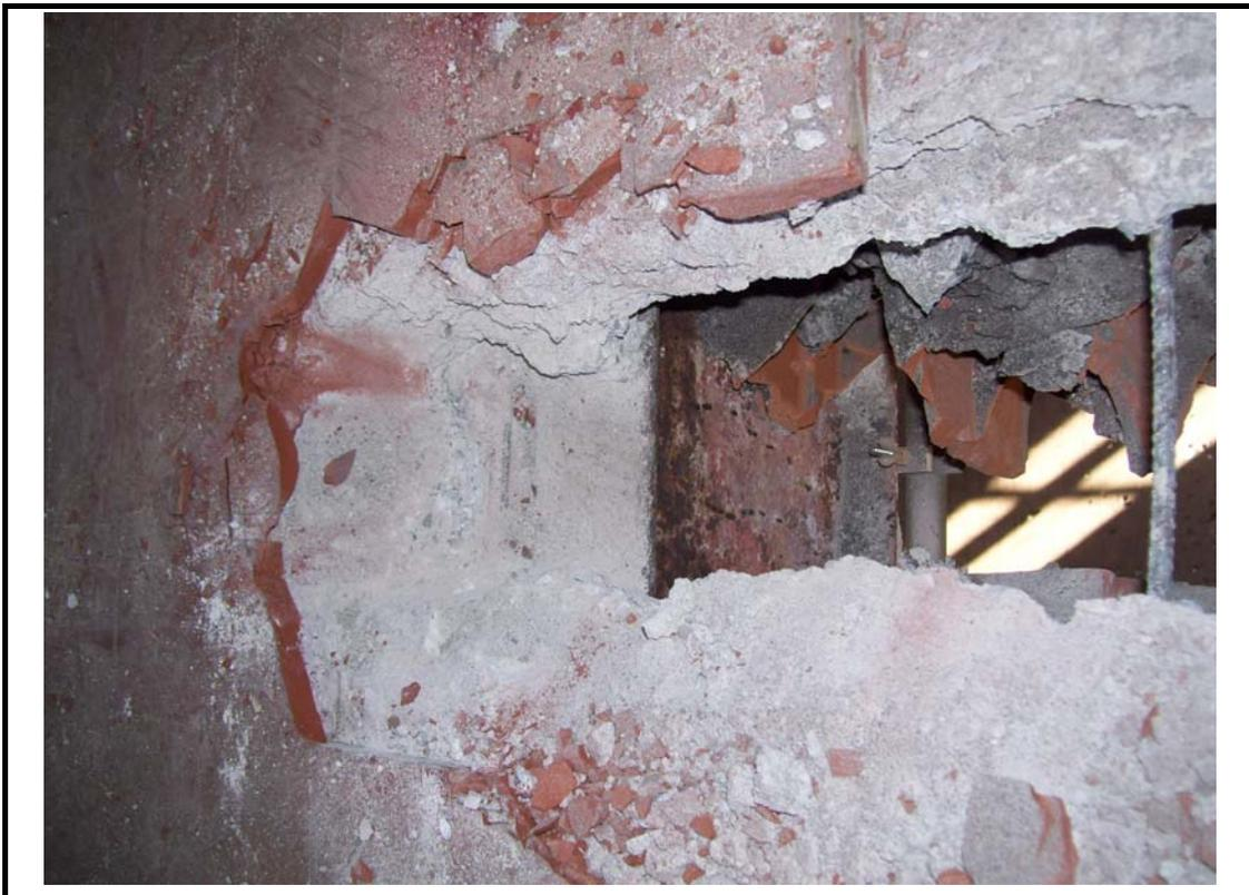
**Fig. 8 – Centro di competenza per lo sviluppo e l'insediamento d'impresa ad alta innovazione tecnologica: Saggio su orizzontamento piano.**
