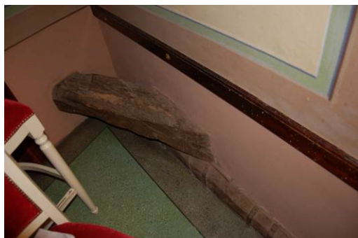
Al livello 3° ordine, nei due palchi laterali al vano occupato dal palco reale, è visibile parte della struttura di appoggio della volta a botte del palco
