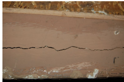
palco terzo ordine n 6 distacco del soffitto
