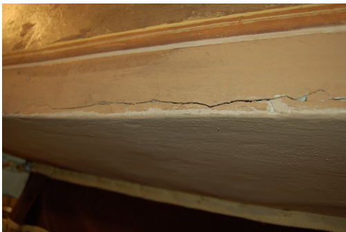
Palco secondo ordine n 20 distacco del soffitto
