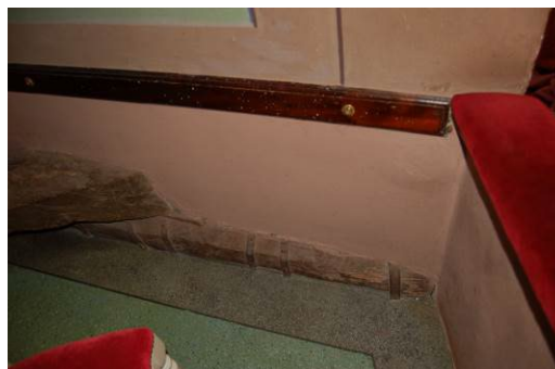
Al livello 3° ordine, nei due palchi laterali al vano occupato dal palco reale, è visibile parte della struttura di appoggio della volta a botte del palco
