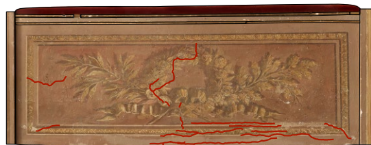
palco terzo ordine n 6 distacco del soffitto
