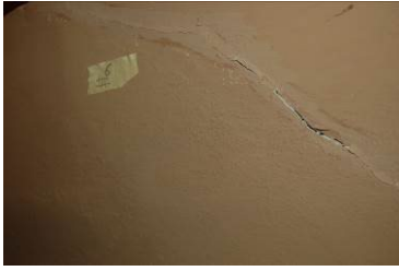
Esempio di distacco sui bordi e sul soffitto palchi terzo ordine n 6 / 19 / 20
