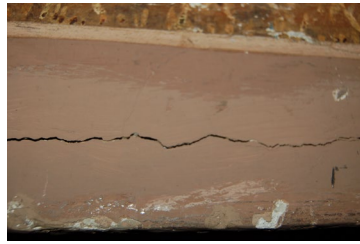
Esempio di distacco sui bordi e sul soffitto palchi terzo ordine n 6 / 19 / 20
