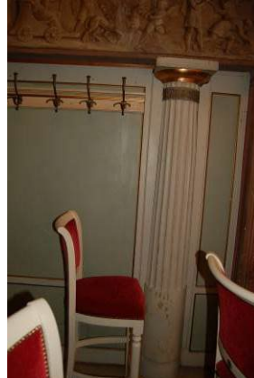
colonna e tamponamento Passaggio verso palchi laterali
