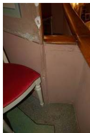
Palco n 6, 4 ordine distacco corrimano e struttura in legno
