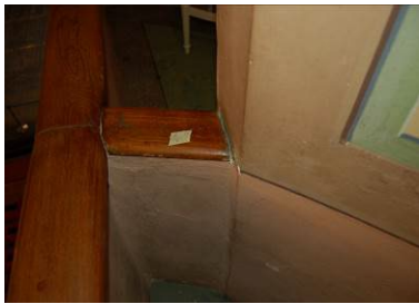
Palco n 6, 4 ordine distacco corrimano e struttura in legno
