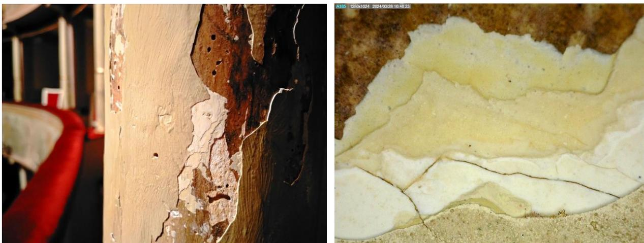
Fig. 15 - A sinistra: dettaglio di una colonnetta del 2° ordine, in cui è visibile la stratificazione delle coloriture dall'attuale, più esterna, fino alla riproduzione del finto marmo, che sotto presenta uno strato bianco sul legno; a destra: immagine della stratigrafia ottenuta con microscopio digitale, dove si distinguono 3 livelli di tinta bianca tra il finto marmo e lo strato attuale di colore grigio-verde (Foto Red Studio 2024).
