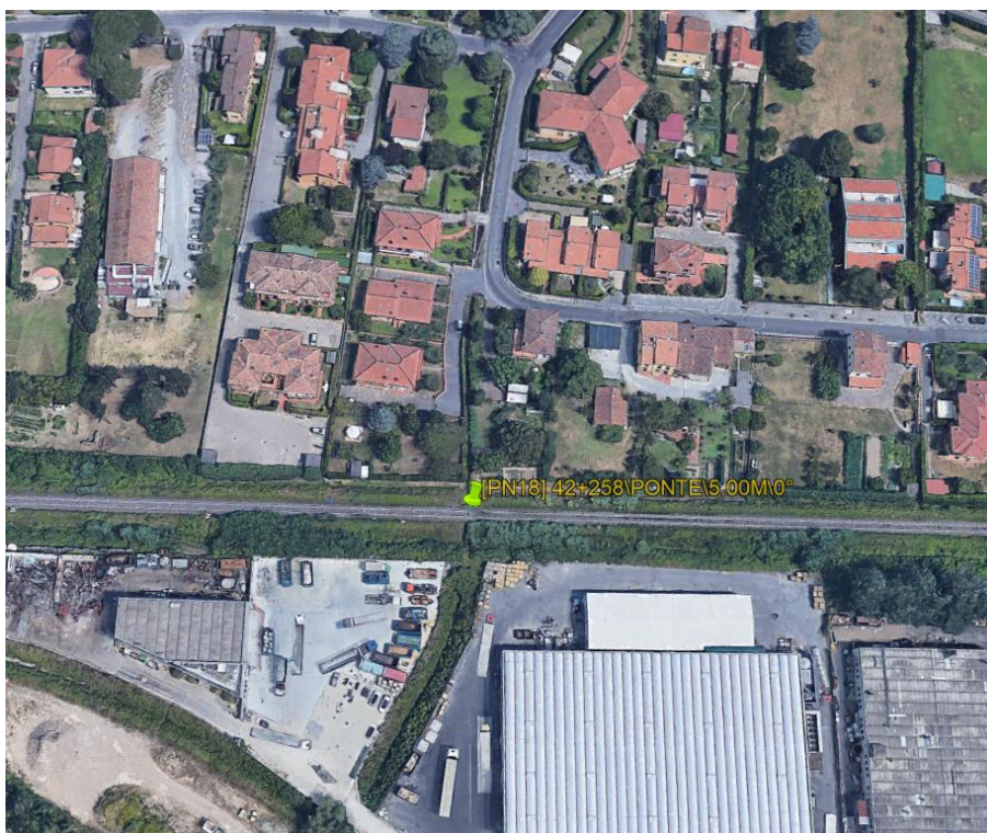
Figura 1-1 Vista satellitare del ponte esistente al km 42+258
