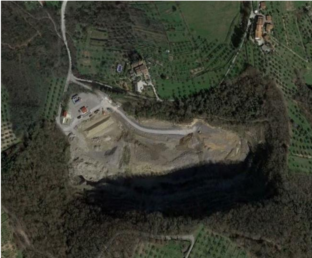
Figura 5.11: Vista aerea della ex cava Bruni
